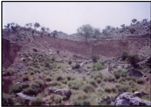
شکل ۳- نمای کلی زمین لغزش
